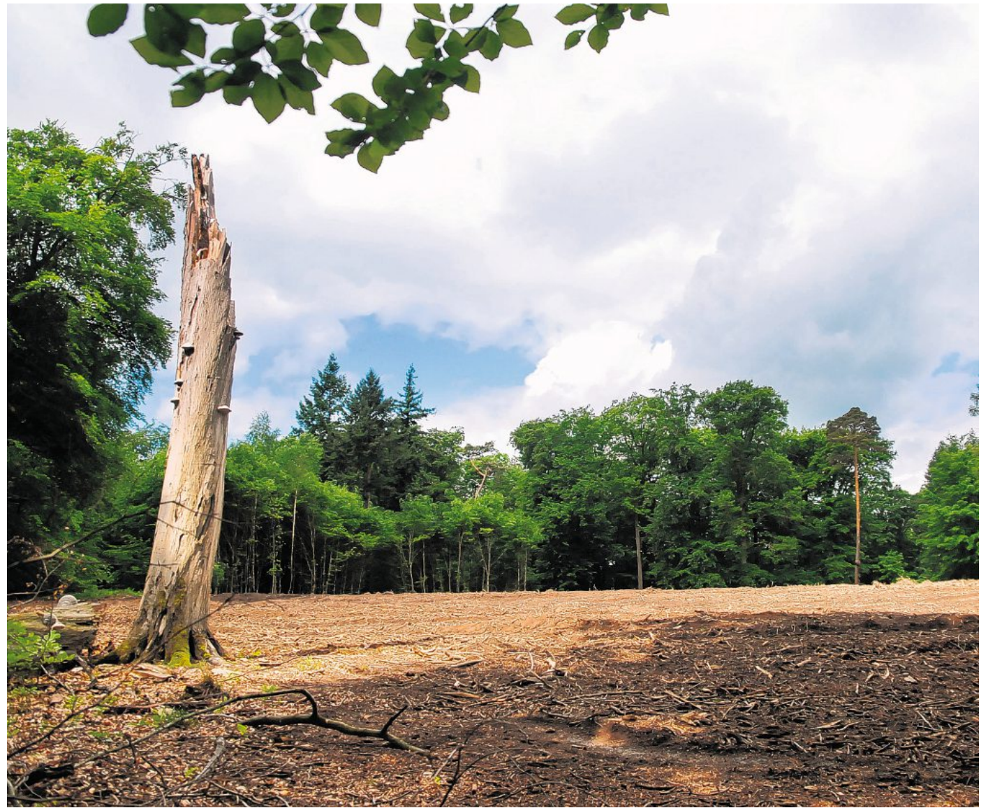
Die Fläche auf dem Tannenkopf ist bereits gerodet. In Kürze sollen hier zwei Windkraftanlagen des Energieversorgers GGEW entstehen. FOTO: GUIDO SCHIEK
